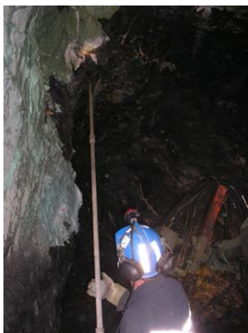
Bild 4: Handskrotning av övergångszon mellan föregående och ny tunnelsalva. Denna zon kunde ej alltid skrotas fullständigt på grund av säkerhetsrestriktioner i skrotarhuvudets rörelsemönster. Observera även den grönaktiga liningen från föregående ortsalva.
